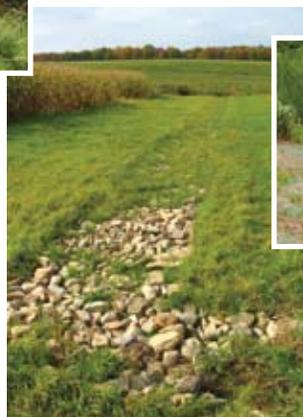
Des déversoirs en bordure des cours d'eau et des voies d'eau engazonnées, drainant les eaux de ruissellement, préviennent l'érosion et le ravinement des champs.
