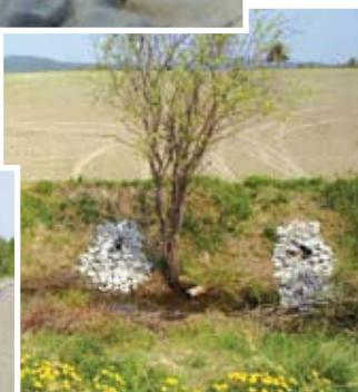
L'encochement des sorties de drains stabilise le sol, empêchant son érosion par les eaux de drainage.
