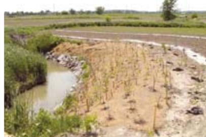
L'enrochement, le nivellement et la plantation de végétaux stabilisent les berges sensibles à l'érosion.
