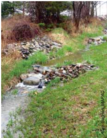
Figure 5.14 Fossé avec seuils de rétention -
