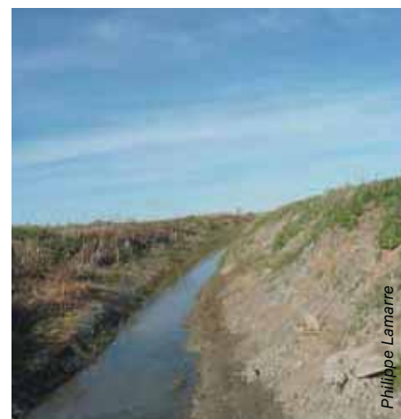
Figure 5.12 Fossé à nu
