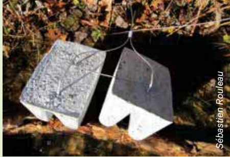
Figure 5.31 Blocs de béton utilisés comme ancrage de troncs d'arbres flottants
