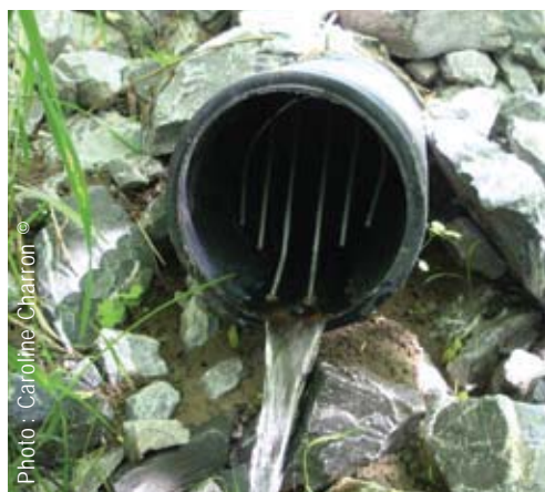
Figure 5. Sortie de drain avec grillage et enrochement empêchant l'accès des rats musqués au drain.
