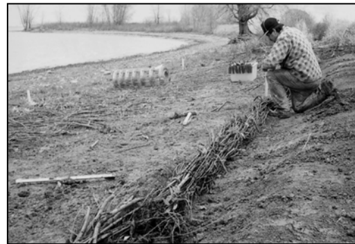
Les fagots sont déposés dans une tranchée et fixés au sol à l'aide de tiges métalliques.
