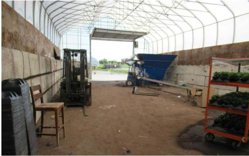
Photo 14 : Intérieur de l'entrepôt de terre
